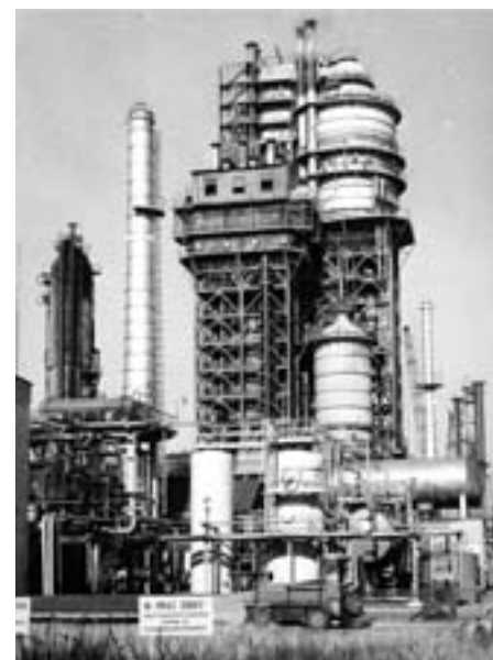
Rys. 1. Fluidalny Krawing Katalityczny I (instalacja już na trwałe wyłączona z ruchu) 8)
