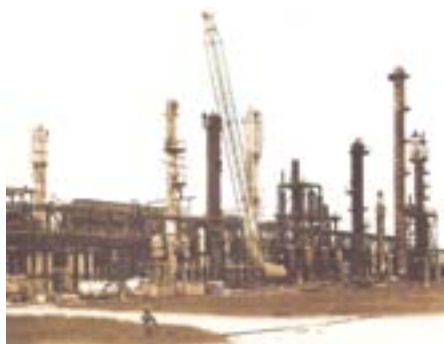
Rys. 2. Olefiny I w budowie 2)
