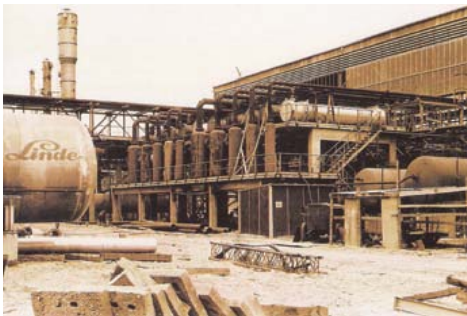
Rys. 3. Olefiny I (instalacja już na trwałe wyłączona z ruchu) 9)
