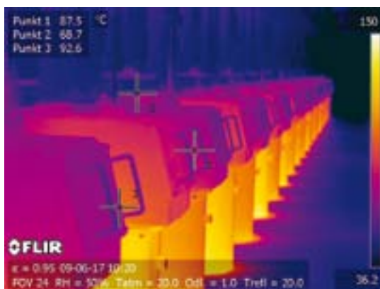
Fot. 1. Pomiar termowizyjny zaworów powietrzno-spalinowych
